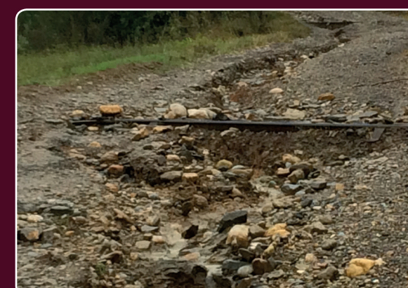
Poursuite réfection voirie suite au inondation
