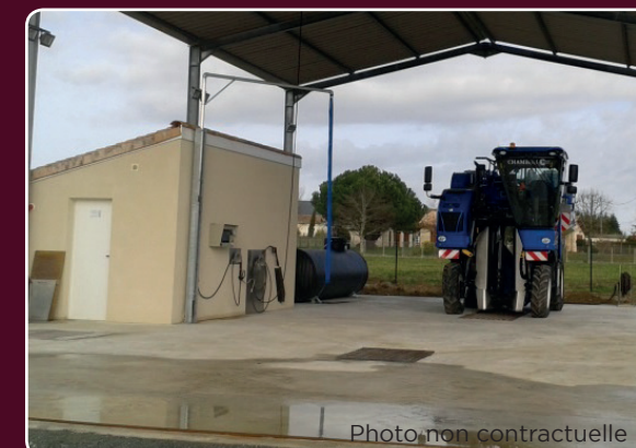
Aire de lavage
